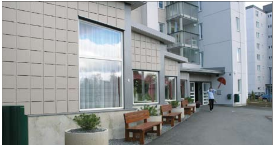
Graniti-julkisivuklinkkeri mekaanisella kiinnityksellä. Kohde: Ruskalinna, Pori.
