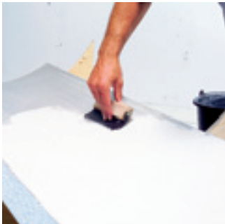
5. Tasoita lasikuitukangas Pukkila Saneerauslaastilla.
