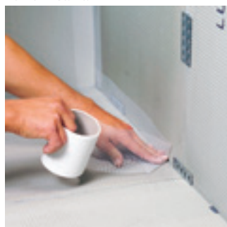
9. Vahvista liitokset levyjen välillä sekä kulmat seinän ja lattian välillä.
