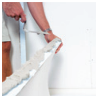
5. Voit myös käyttää Pukkila Saneerauslaastia. Huomioi laastin pidempi kuivumisaika.
