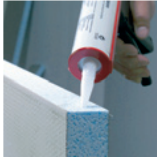
2. Kaikki liitettävät pinnat liimataan COL-PU liimalla tai Pukkila Saneerauslaastilla. Jos käytät laastia kuivumisaika on pidempi.
