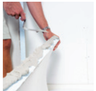
11. Levitä Pukkila Saneerauslaastia tai COL-PU liimaa yhteen liimattaviin reunoihin.
