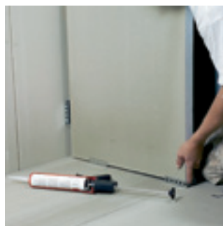
6. Asenna levy kiinnikkeisiin.
