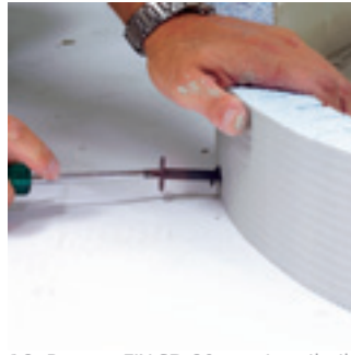
18. Ruuvaa FIX SD 80 ruuvit paikoilleen
