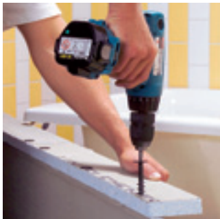
4. Kierrä ruuvit paikoilleen. Tee hyllyn leveys tarpeiden mukaan.
