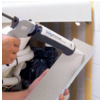
6. Asenna LUX rakennuslevyistä tehdyt tuet ammeen sivuseinään.
