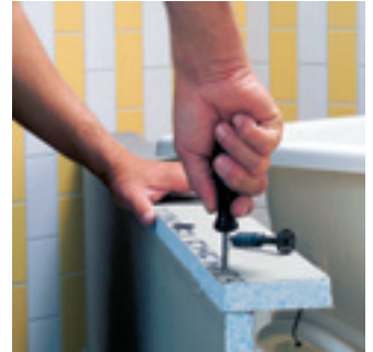
3. Nopeuttaaksesi asennusta, kiinnitä osat FIX SD 80 ruuveilla. Tee ensin reikä ruuvimeisselillä, jotta ruuvi menee suoraan.
