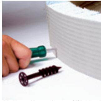
17. Tee reiät ruuvimeisselillä. Käytä FIX SD 80 kiinnitysruuveja, jotta kappaleet pysyvät paikoillaan kuivumisen ajan. Huom! Käytä kiinnityksessä Pukkila Saneerauslaastia tai COL-PU liimaa.
