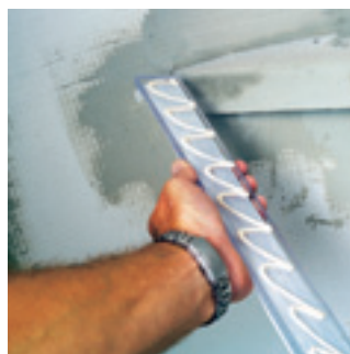
10. Lasioven tai liukuoven kiinnittä- mistä varten liimaa PRO MAK vahvikelista levyyn. Peitä lasikuitunauhalla ja laastilla. Laatoituksen jälkeen lis- taan voidaan porata ja ruuvata.
