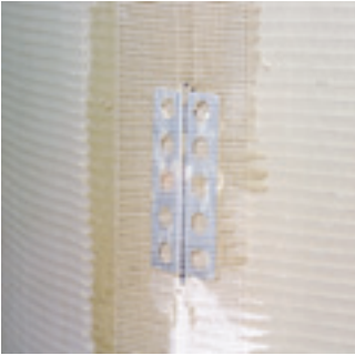
20. Vahvista kaikki kulmat ja liitokset ARM 100 lasikuitunauhalla.
