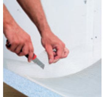
4. Leikkaa ARM 600 lasikuitukangas ja aseta se levyille.
