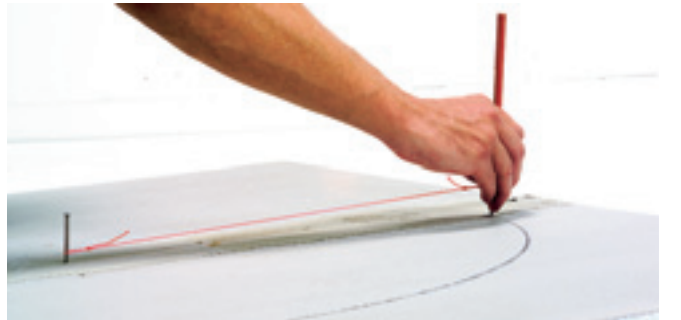
7. Tarvitset ympyrän muotoisen levyn asennustueksi pohjalle sekä hieman yli seinän keskikohdan. Levyksi suositellaan LUX-levyä, joka toimii samalla lattiana/kattona. Laita naula levyn keskelle, sovita naru suihkun sisähalkaisijan mukaan ja piirrä ympyrä.
