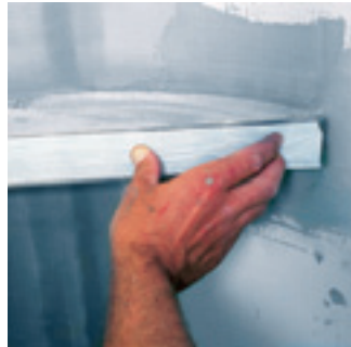
25. Suihkusekoittaja kiinnitetään PRO MAK listaan. Poraa reikä laattaan ja pienempi reikä PRO MAK listaan, jotta ruuvi kiinnittyy hyvin.
