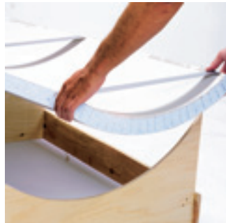
6. Voit vapauttaa muotin tukemalla levyä teipillä laastin kuivumisen ajaksi. Jatka samalla tavalla kunnes kaikki osat ovat valmiina.
