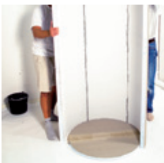
12. Aseta pohjalevy lattialle ja asenna kappaleet sen ympärille.
