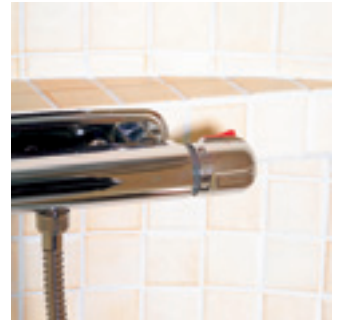
27. Suihkusekoittaja asennettuna hyllyn reunaan.
