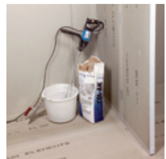
11. Seinä on valmis. Seuraava työvaihe on lasikuitunauhan tasoitus.
