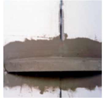
23. Valmista puolikuun muotoinen levy pala suihkusekoittajan kiinnittämistä varten.
