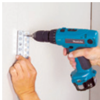
2. Asenna yhdistelmäkiinnikkeet seinään ja lattiaan. Jos seinä on laatoitettu, kiinnitä COL-PU liimalla.
