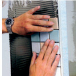
26. Laatoitus voi alkaa. Käytä reuna-listaa jotta saat siistin lopputuloksen.
