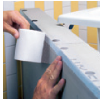
5. Kaikki liitokset ja saumat vahvistetaan ARM 100 lasikuitunauhalla.
