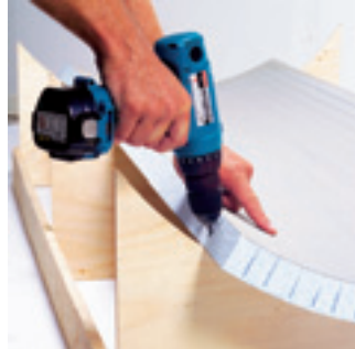
3. Aseta levy muottiin urat ylöspäin ja kiinnitä se muottiin ruuveilla.
